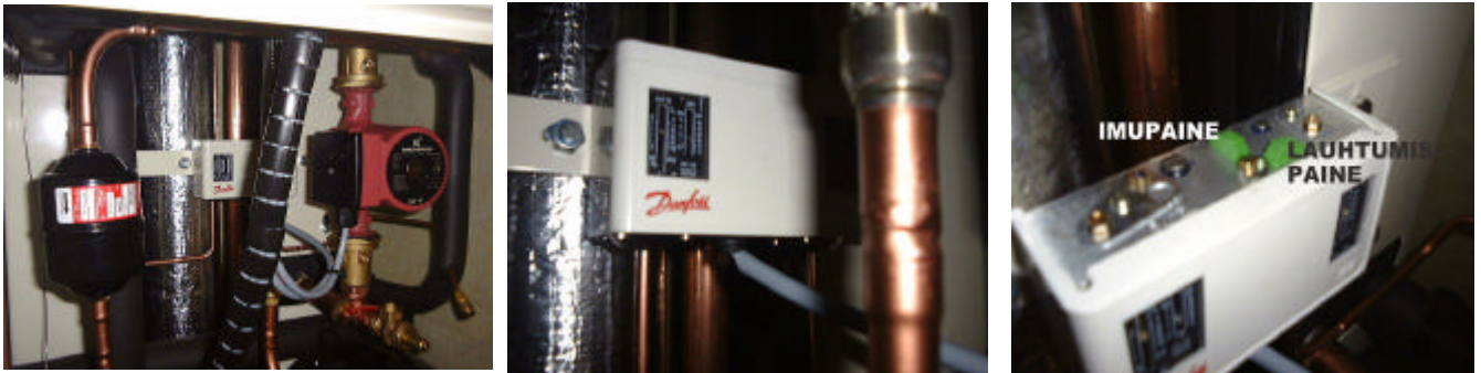
Kuva 16.1 Pressostaatin sijainti ja lähikuva kuittauspainikkeista
