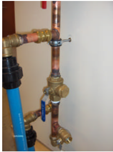
Kuva 13. Pumpun pyör.suuntanuoli ( vas. ), täyttöventtiilit ja täyttöpullo ( oik. )
